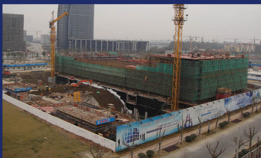
06 惠山信息港施工现场
